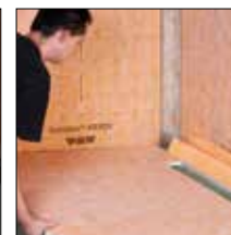
til 3. Skub faldelement under kanten af rende-legemet
