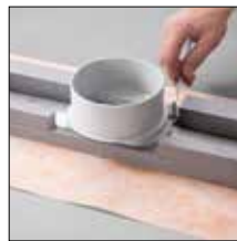
til 3. Skrue adapteren på igen
