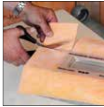
til 1. Tilskær KERDI-manchetten
