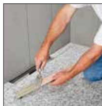
til 5. Påfør tyndlagsmørtel på belægningsholderen
