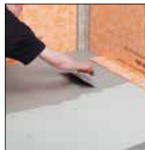
til 6. Påfør fliseklæber
