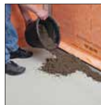
til 3. Påfør nivelleringslag
