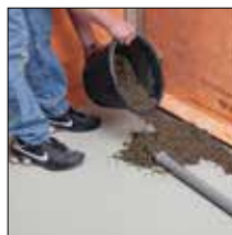
til 6. Påfør hældningslag
