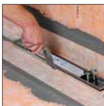
til 3. Underbeklæd ramme/ læg fliser heldækkende
