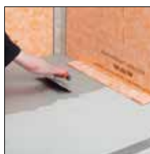
til 7. Påfør fliseklæber
