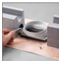
til 2. Skru adapteren på igen
