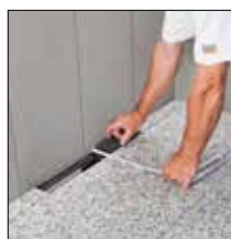
til 4. Mål belægning til belægningsholderen...
