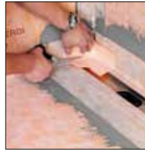
til 2. Lim KERDI-manchet/tilskær KERECK-inderhjørne
